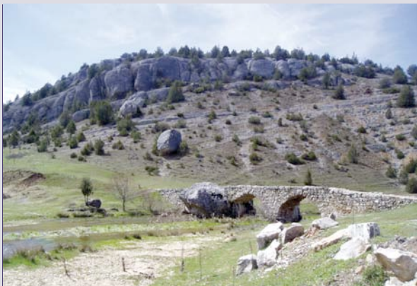
Desprendimiento de bloques en la zona del puente Campanario (J. Preciado).
